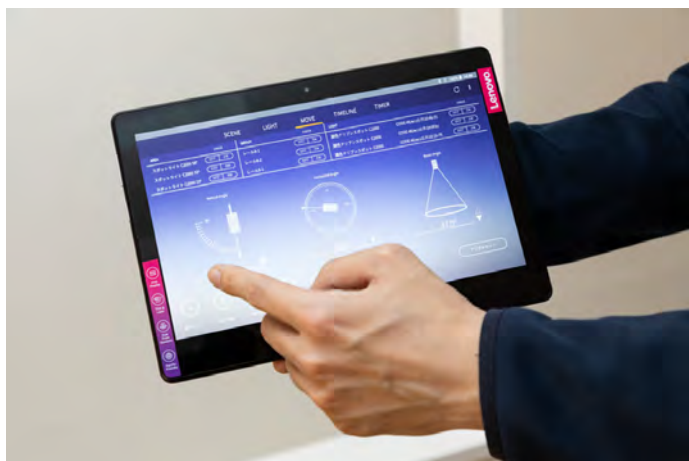
コネクテッドプラスの「MOTOR DRIVEN SPOT LIGHT」では、100台以上の照明器具(スポットライト)をタブレットから自在にコントロールできる。
