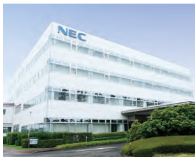
国内の修理を一手に担う NECパーソナルコンピュータ 群馬事業場
